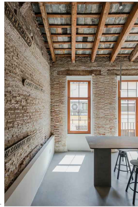
A- Desmontaje e instalación de cubierta nueva con aislamiento por el exterior. Conservación de las vigas actuales de madera restaurandolas y tratandolas.
