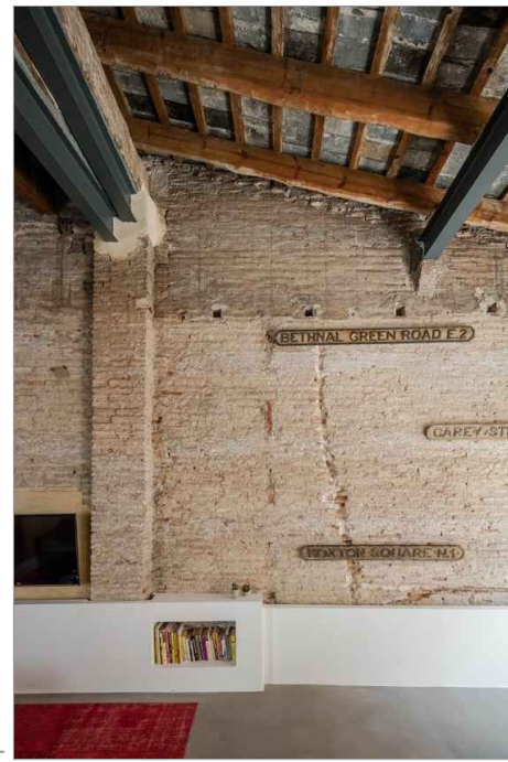
A- Desmontaje e instalación de cubierta nueva con aislamiento por el exterior. Conservación de las vigas actuales de madera restaurandolas y tratandolas.
